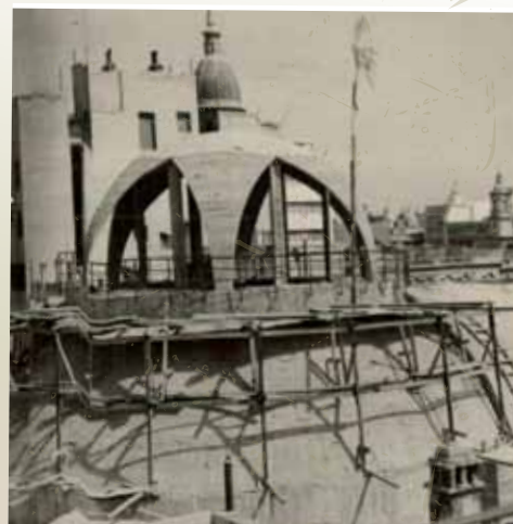
Construcción de la Cúpula del Templo.
