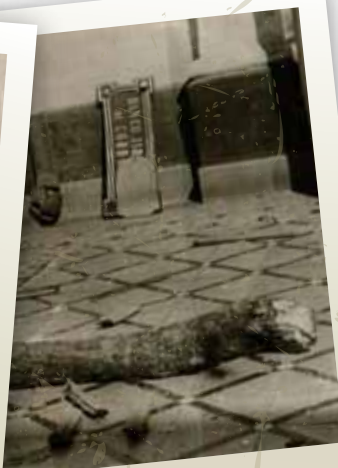
Roturas en las oficinas del BIC en calle Alvear. 1945
